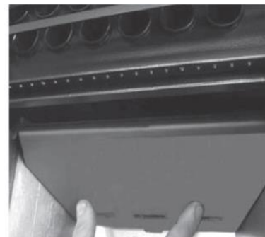
Fig. 14: levantar la placa cortafuego
